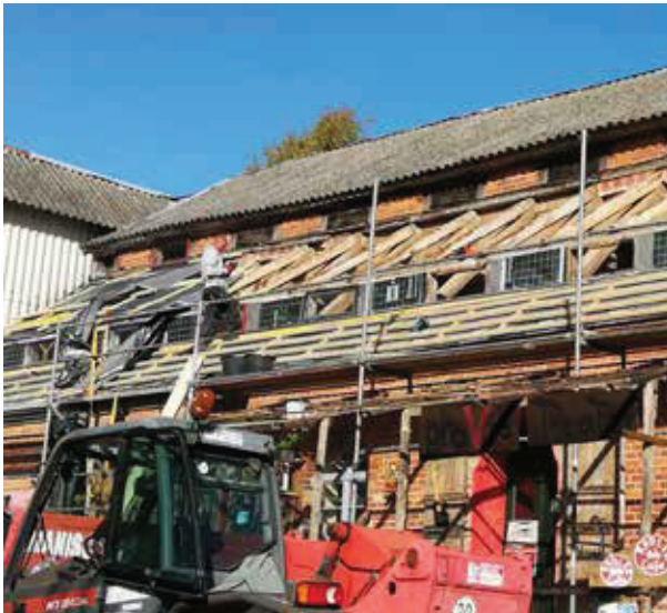
Auf der Dachbaustelle in Hohenbüssow © Leo Kraus
